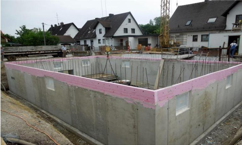
**Dickbeschichtung von Außenwänden an Bauwerken nach DIN 18195.**
